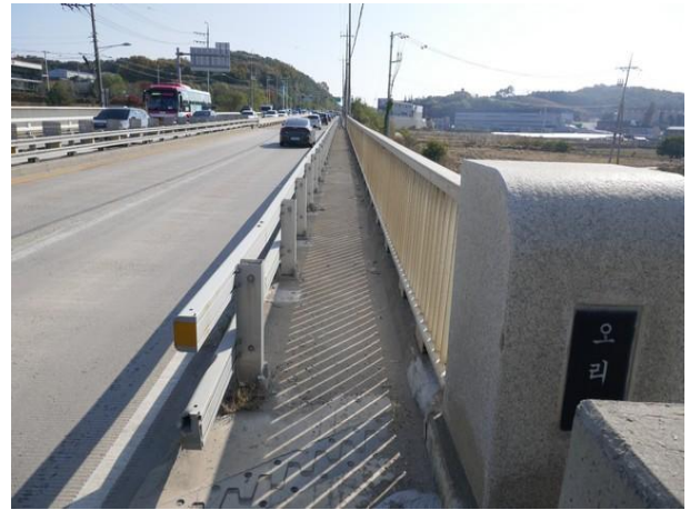
난간 및 연석 전경
